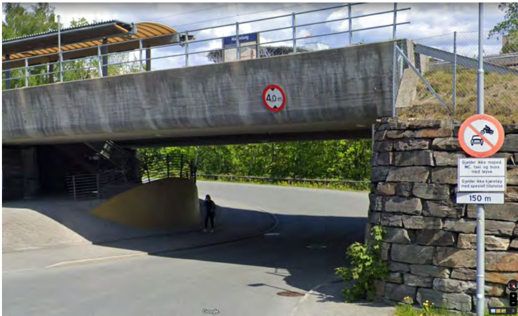
Figur 9: Høydebegrensning under jernbanen vest for Ceciliebrua
