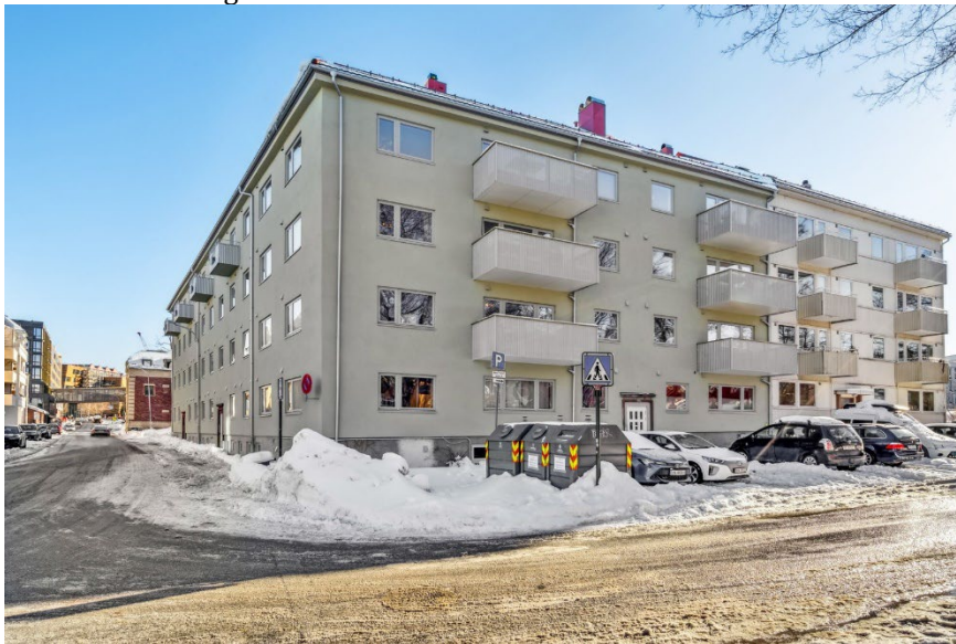
Figur 1: Perspektivbilde av fasader i Ragnhilds gate 1 og 3 (bilde fra salgsannonse for leilighet i Ragnhilds gate 1c)
