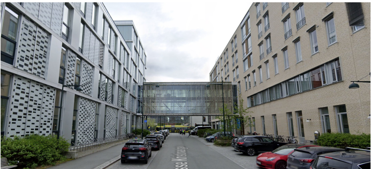
Eksempel på bruforbindelser i to etasjer på St. Olavs hospital
