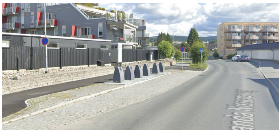
Dagens løsning må flyttes ut mot Fernanda Nissens veg
