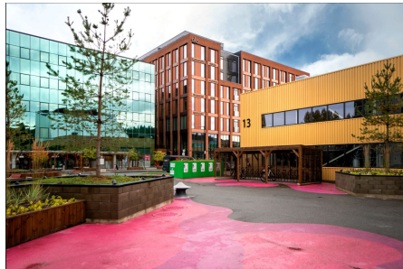
Blanding mellom nytt og transformert - Sluppen
