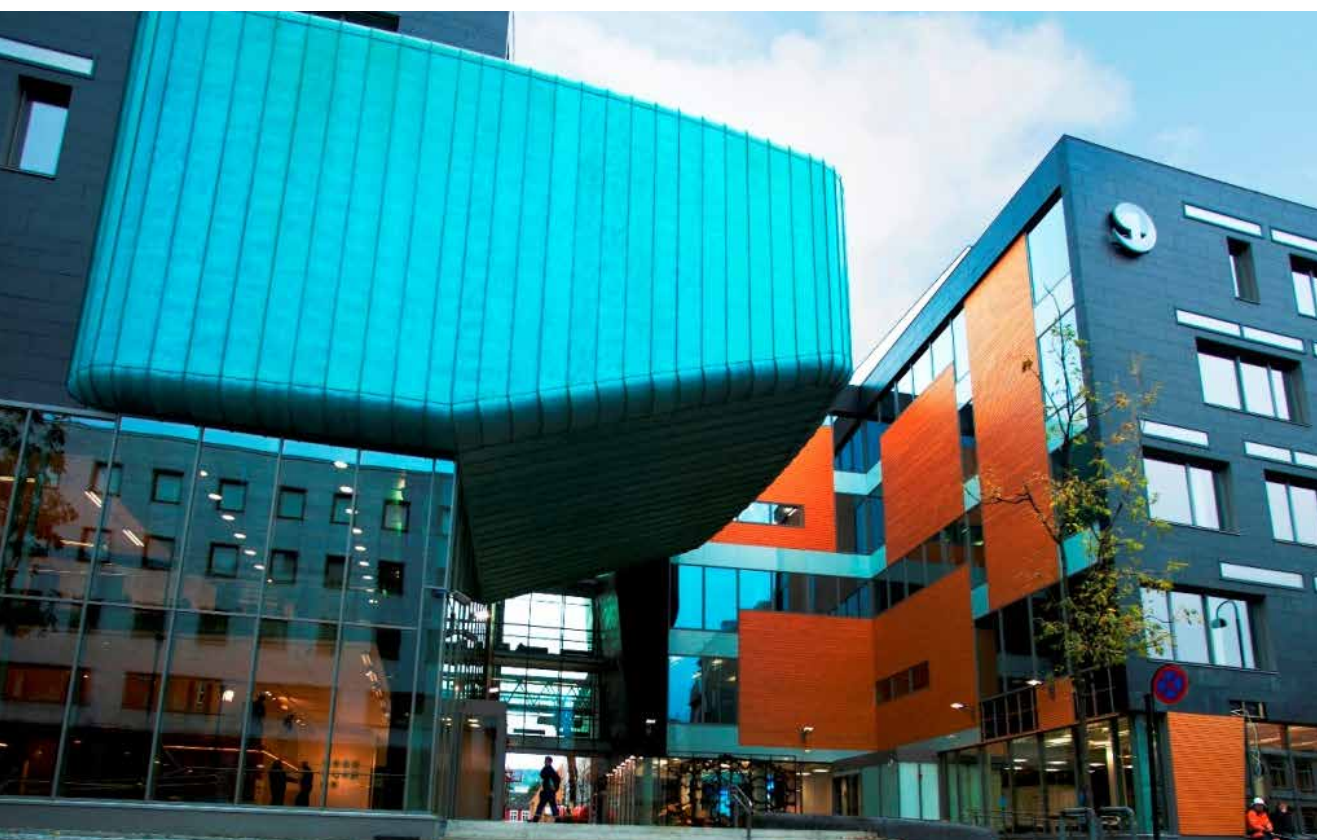
Bilde 18. Sparebank1 i Søndre gate . Miljømål sto sentralt gjennom hele prosjekterings- og byggeprosessen, og prosjektet ble tildelt kommunens energisparepris. Arkitekter: Agraff. Foto: Jan Christian Sørli.
