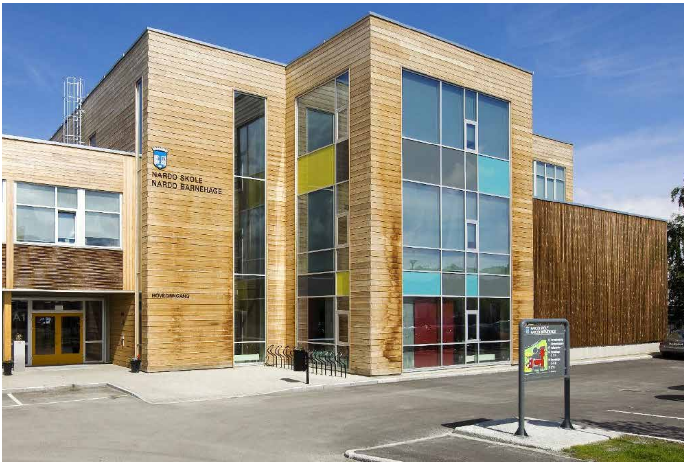
Bilde 19. Kommunen viser vei med Nardo skole. I prosjekterings- og byggefasen ble det lagt avgjørende vekt på lavt energiforbruk, miljøvennlige byggematerialer og et sunt innklima. Arkitekt: Eggen Arkitekter. Foto: Trondheim kommune
