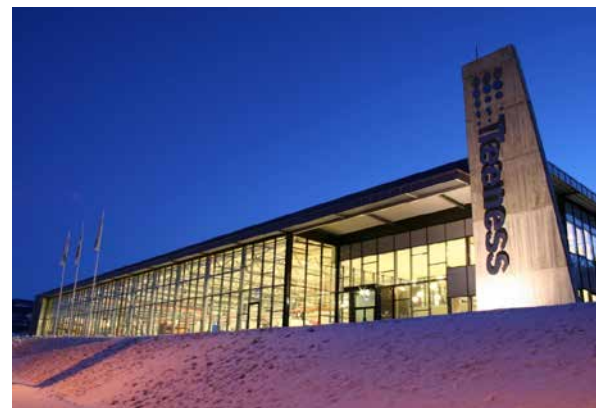
Bilde 15 Arkitekt Odd Thomessens utforming av industribygget for Teeness viser at også slike bygg kan ha estetiske kvaliteter, og bidra både til byen og til arbeidsmiljøet. Foto: Odd Thomessen.
