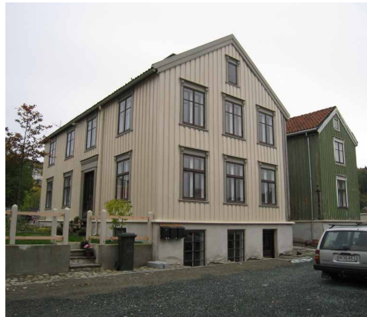
Bilde 17. Langvolden ble bygget ca 1850, flyttet i 2005, og istandsatt av arkitektene Bente Egeland og Trond Eide. Originale bygningsdeler er istandsatt og bevart. Fra å være helt nedslitt, er huset nå et praktbygg. Foto: Arkitektene
