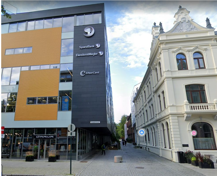
Slik er en 2 m utkragering i et bygg i Trondheim
