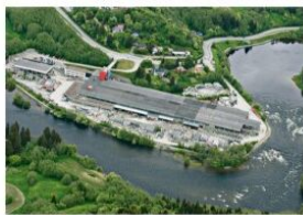
Bildet viser Levøya og fabrikkens tilbake i 2006. Foto: MORTEN ANTONSEN
