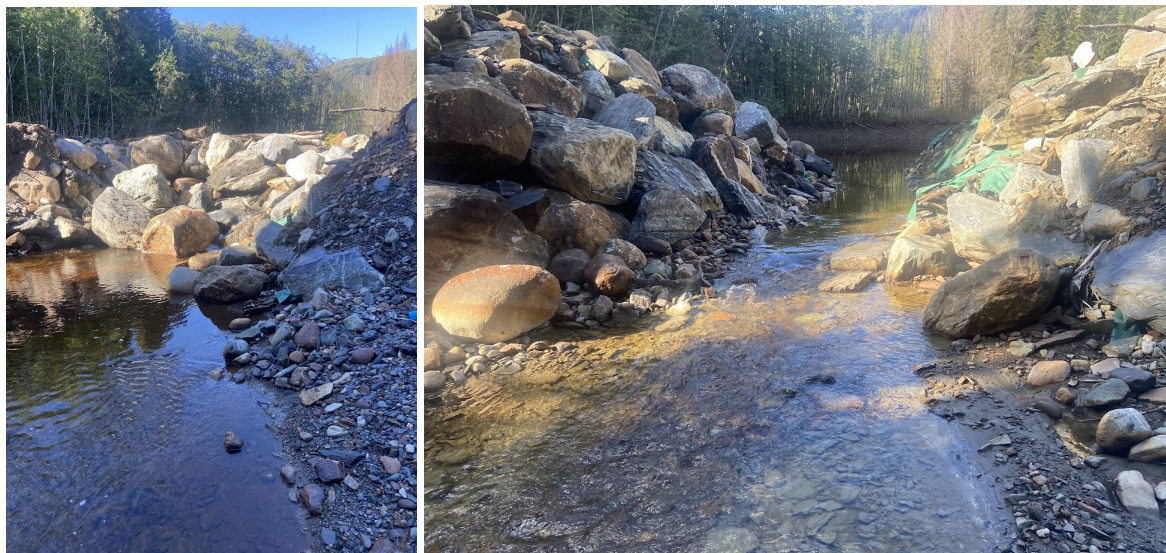
Figur 7.31. Vandringsvei for nidelvørret ved demning stengt i august 2022 (til venstre) og åpen etter tiltak i september 2022 (til høyre).
