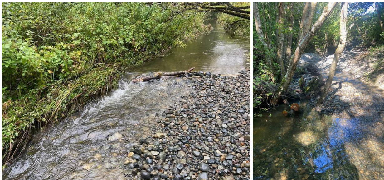
Figur 7.18. Utlegging av gytegrus er gjennomført i Steindalsbekken sommeren 2022 og vandringsforholdene opp mot kulvert Sandflakvegen er utbedret (til høyre).
