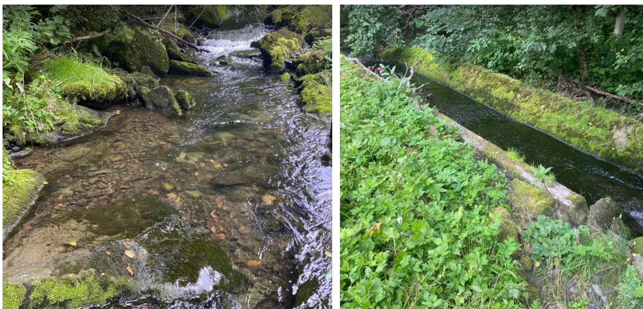
Figur 7.10. Stasjonsområde 3 i Heimdalsbekken (t.v.) er lokalisert nedstrøms en betongkonstruksjon (t.h.) som er svært vandringshindrende for ørret, og trolig vandringsbarriere for ungfisk under 7-8 cm.
