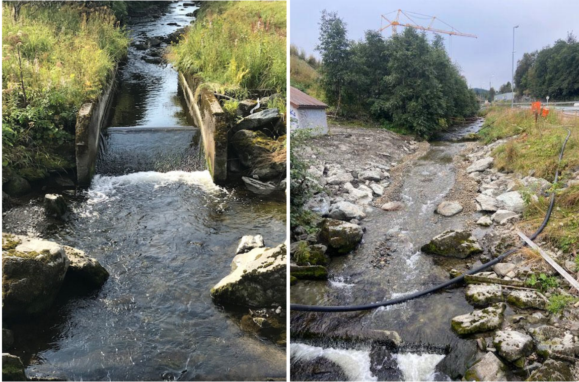
Figur 7.5. Vandringshinder (betongrenne til venstre) i nedre del av Leirelva er fjernet sommeren 2022 for å lette oppvandring for alle størrelser av sjøørret og laks.
