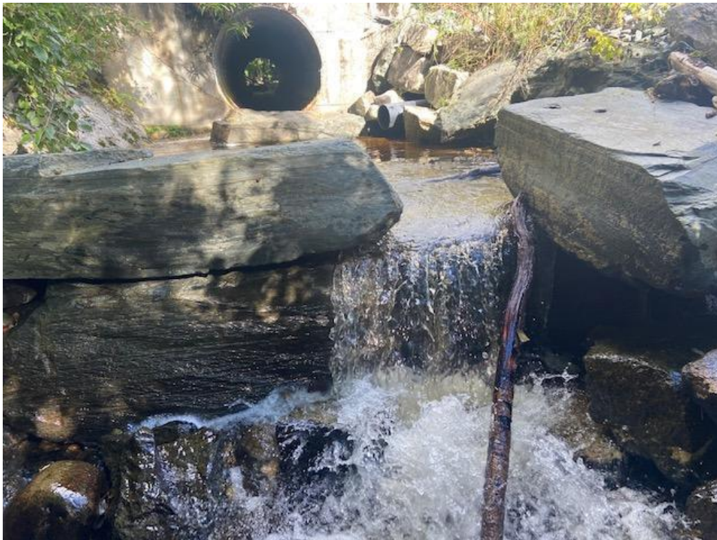
Figur 7.48. Problemområde i fisketrappløsning i Lauglobekken, som stoppet laks fra videre gytevandring i bekken høsten 2021. Punktet ble utbedret i 2021, men kan fortsatt å gi vedvarende vandringsproblemer for mange størrelser av gytefisk, også sjøørret, i årene som kommer, og bør avbøtes.
