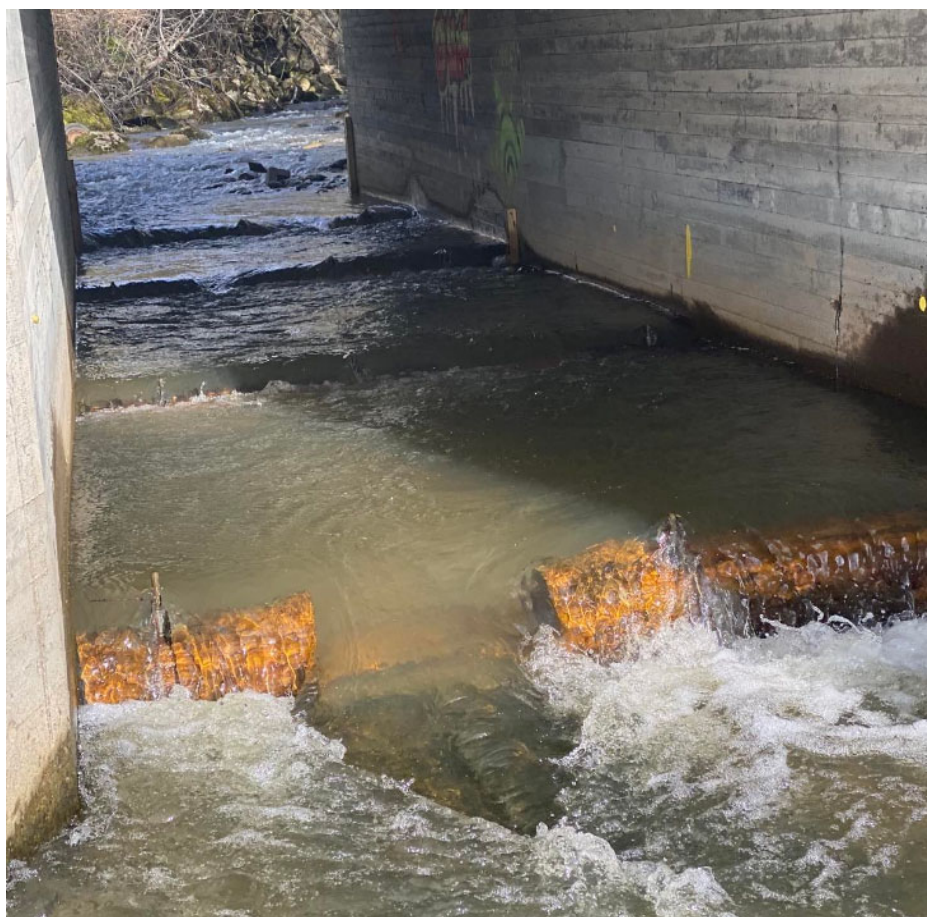
Figur 7.65. Utbedring av vandringsmulighetene for sjøørret i kulvert gjennom Bynesveien ble gjennomført i 2019.
