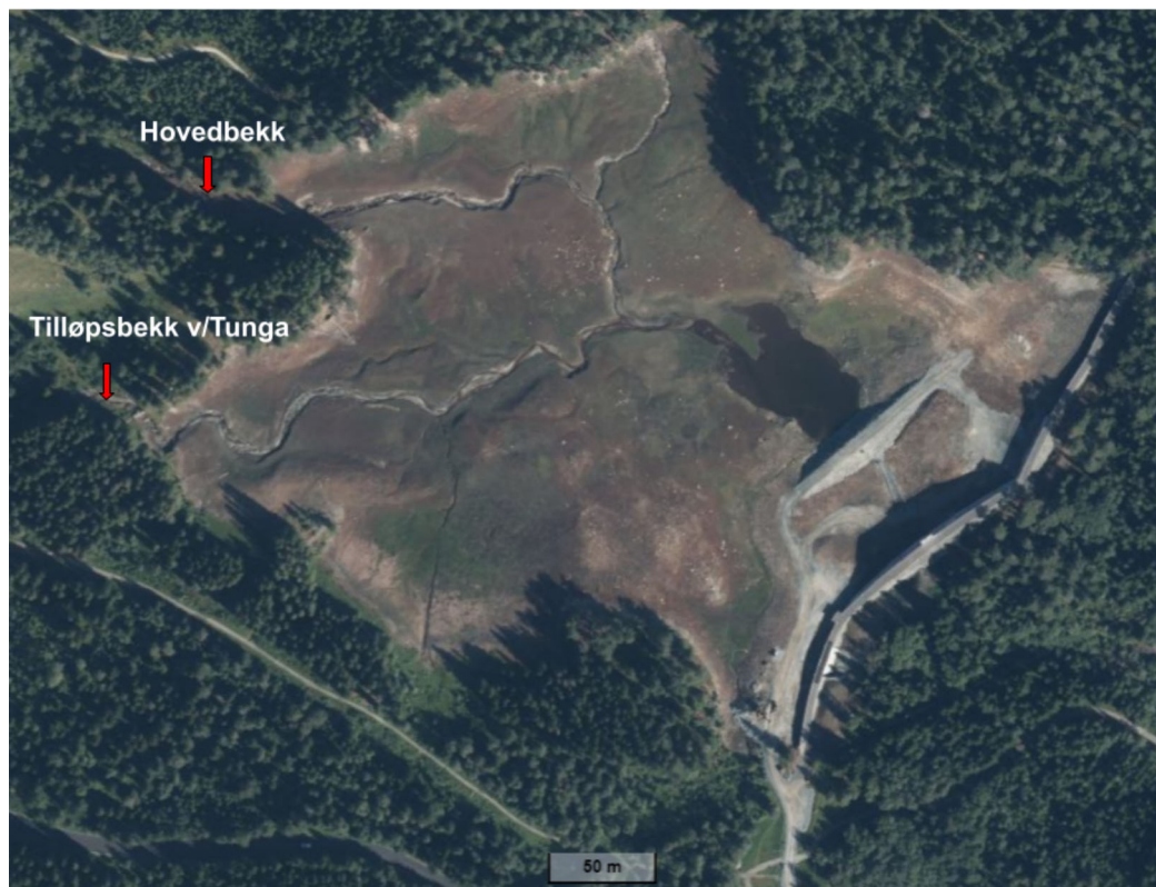
Figur 7.85. Flyfoto av Baklidammen i 2021 da dammen var nedtappet. Et lite restvannvolum for overlevelse av fisk kan ses ved demningen til høyre. Elfiskestasjoner i bekkene er angitt med rød pil.
