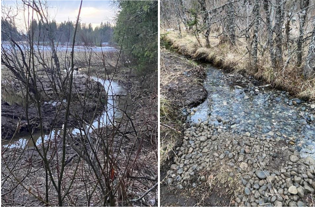
Figur 7.80. Tilløpsbekken til Lianvatnet er gravd ut i nedre del (venstre) og gytegrus er lagt ut (høyre).
