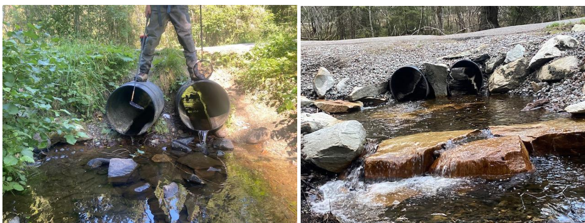
Figur 7.75. Utbedring av vandringsmuligheter for ørret gjennom kulvert. Til venstre: Før tiltak Til høyre: Etter tiltak i 2022.
