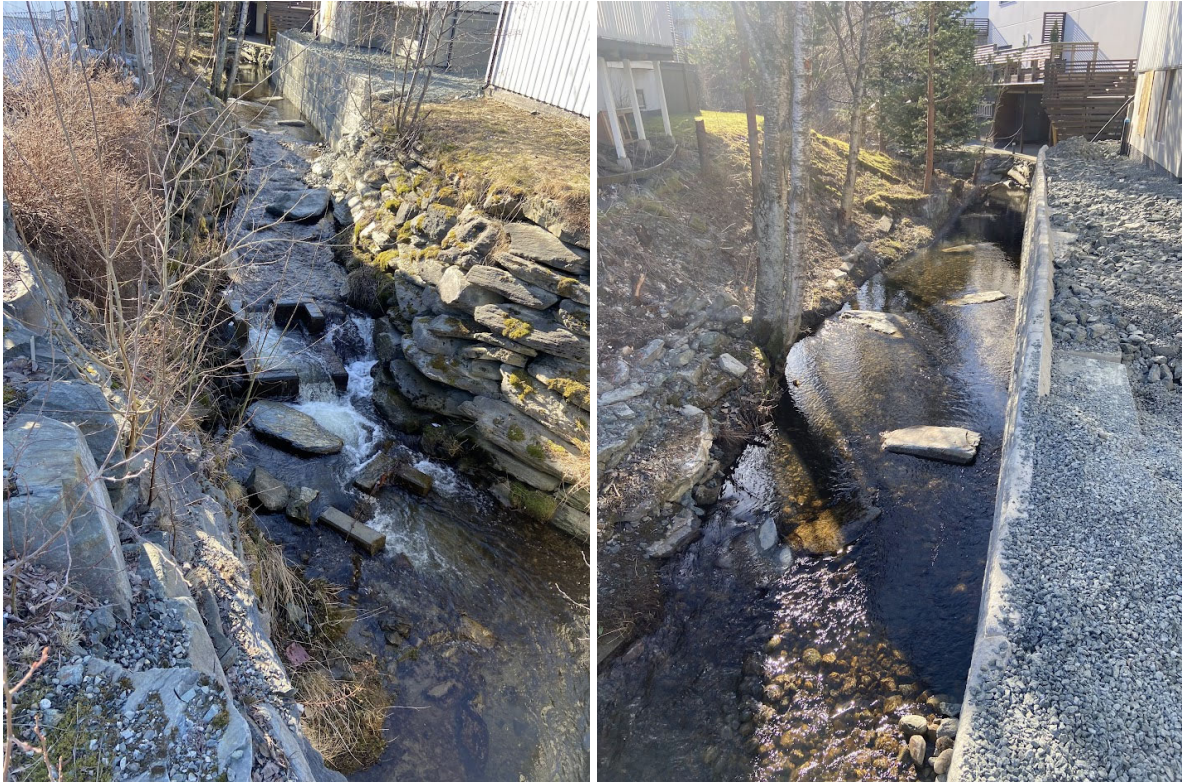
Figur 7.34. Habitattiltak er gjennomført i Sjøskogbekken i 2022. Til venstre: utbedring av fisketrapp. Til høyre: partier har fått tilført gytegrus og stein.
