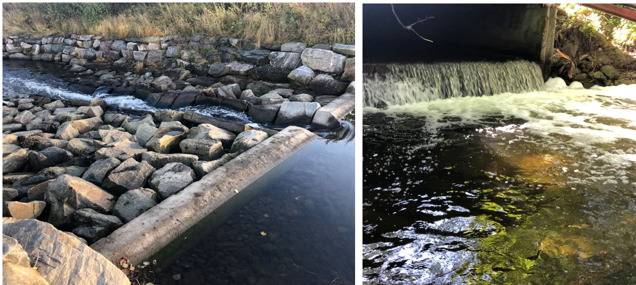
Figur 7.35. Til venstre: Utformingen av terskelområdet i nedre del er ikke optimal for fiskevandring. Til høyre: elvelukking under papirfabrikken.
