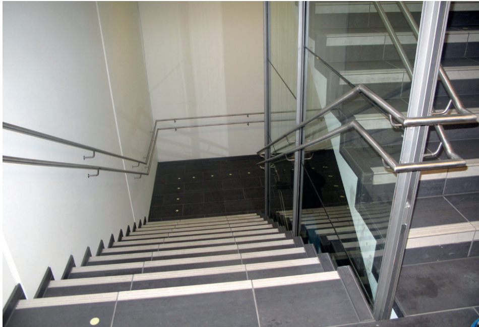
Håndløper på begge sider av trappeløp. Markering av alle trappeneser.
