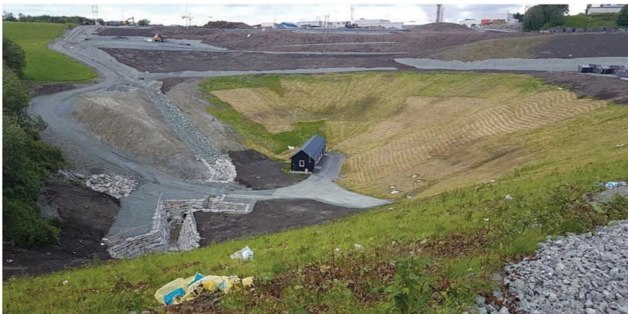
Figur 21: Heggstadmoen avfallsdeponi er nå dekket til med tette flater. Sigevann samles opp og pumpes videre til rensing. Sigevannsstasjonen sees sentralt i bildet. Rent overvann går til Heggstadbekken. Deponigassen ledes til oksidasjonsvinduer. Området ble offisielt avsluttet og gikk over til etterdrift 1. august 2018. Foto: Trondheim kommune.
