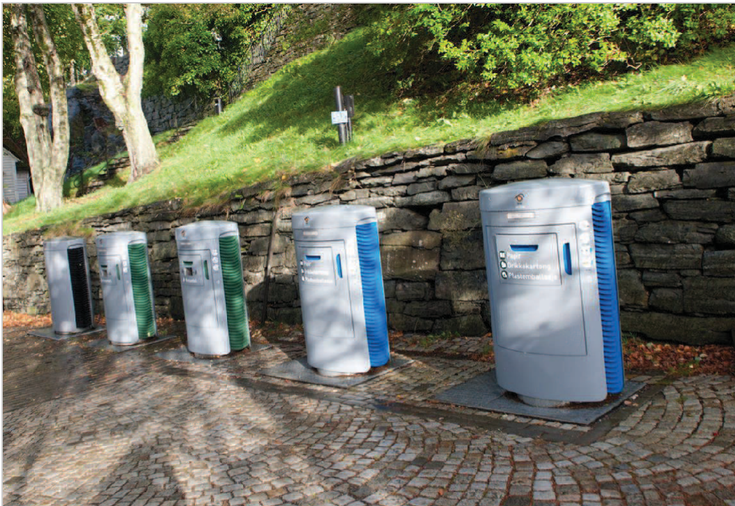
Figur 24: Innkastsøyler i avfallssuget i Bergen sentrum. Foto: Kristin Hauge Klemsdal, Bergen kommune.
