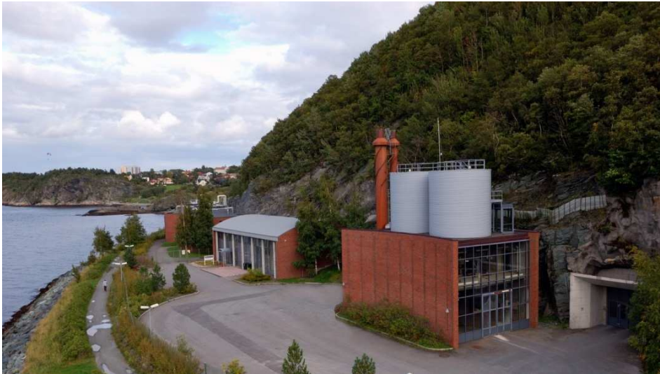
Figur 4.13: Ladehammeren rensanlegg. Bildet viser servicebygget og daganlegget. Foto: Trondheim kommune
