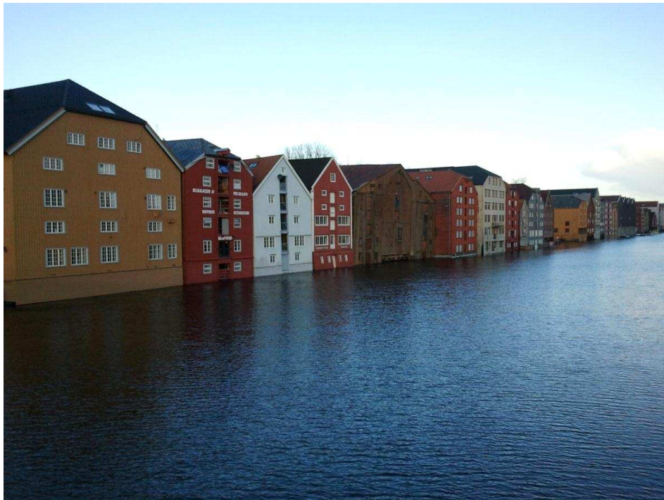
Figur 2.4: Situasjon med høy vannstand i fjorden og Nidelva, 25. november 2011 kl. 11.00. Foto: Trondheim kommune
