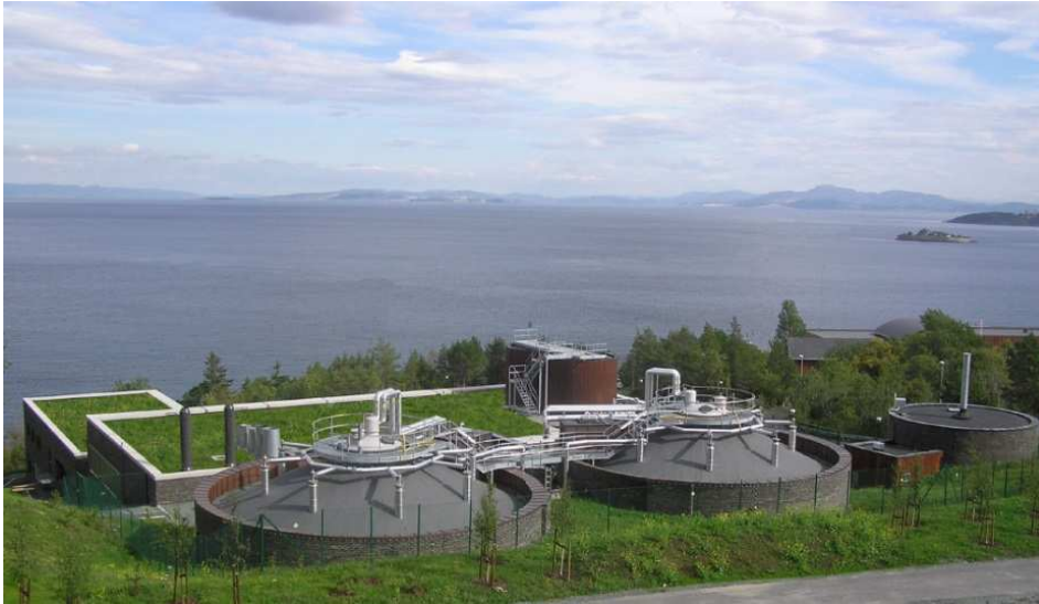
Figur 4.12: Høvringen rensanlegg. Bildet er tatt mot nord-øst og viser toppen av råtnetankene som ligger ovenfor daganlegget og servicebygget. Foto: Trondheim kommune
