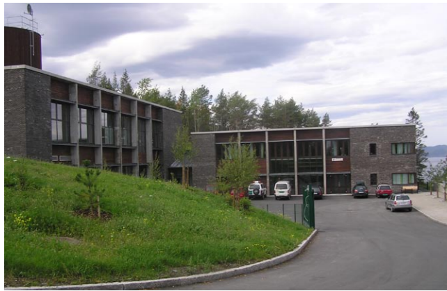
Slambygget og administrasjonsbygget
