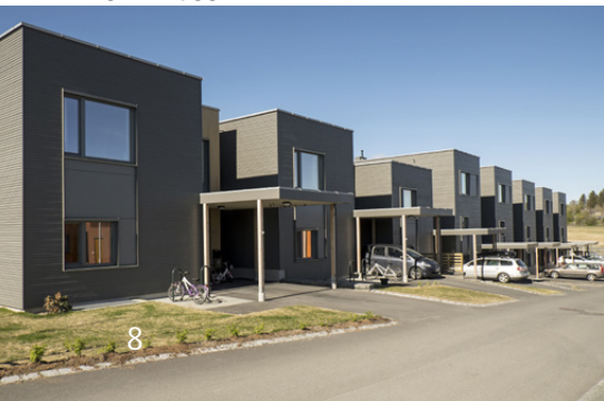
Eneboliger - byggetrinn B1.
