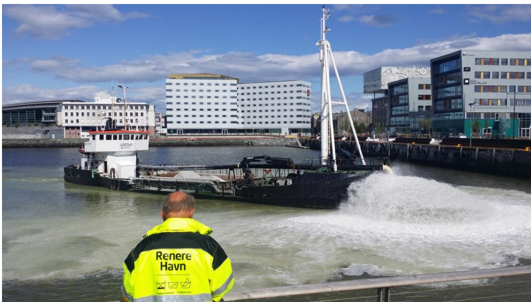
Figur 9: Tildekking med slurry via diffusor i Brattørbassenget.
