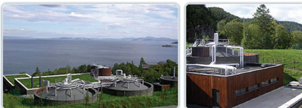
Figur 2: Høvringen renseanlegg. Foto fra www.trondheim.kommune.no
