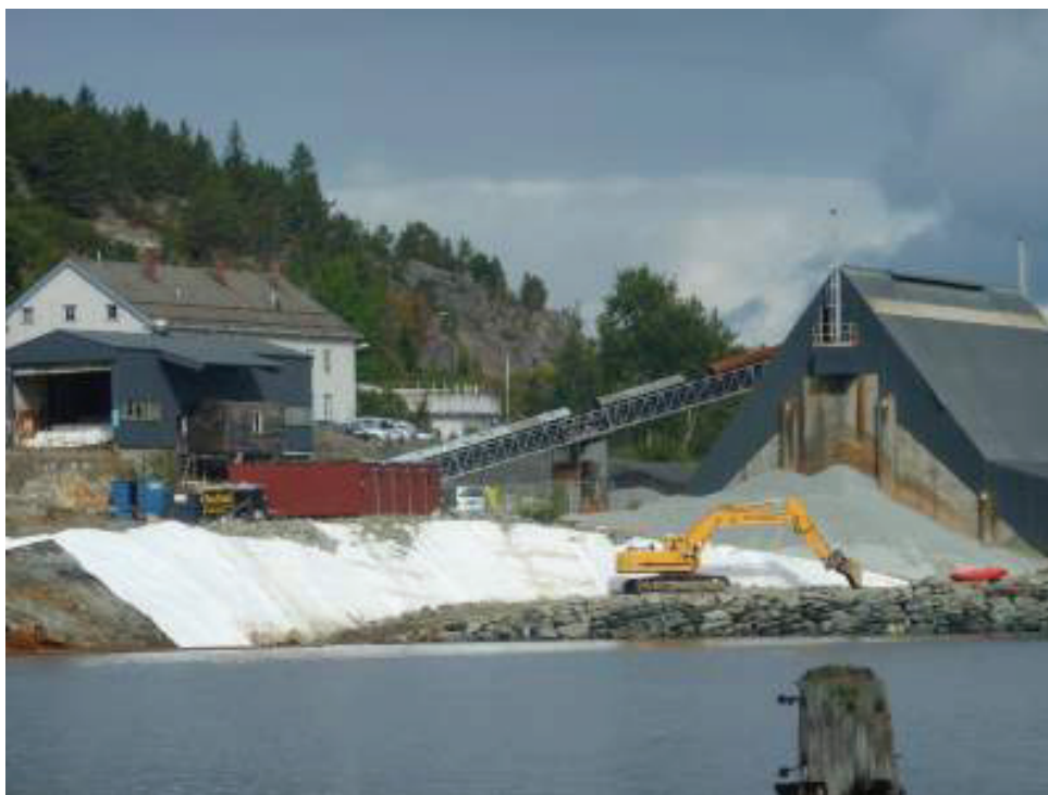
Figur 3: Fra opprydningen i Killingdal-området i august 2010, hvor forurenset grunn ble tildekket og det ble plastret med stein ut mot sjøen. Foto: Trondheim kommune.
