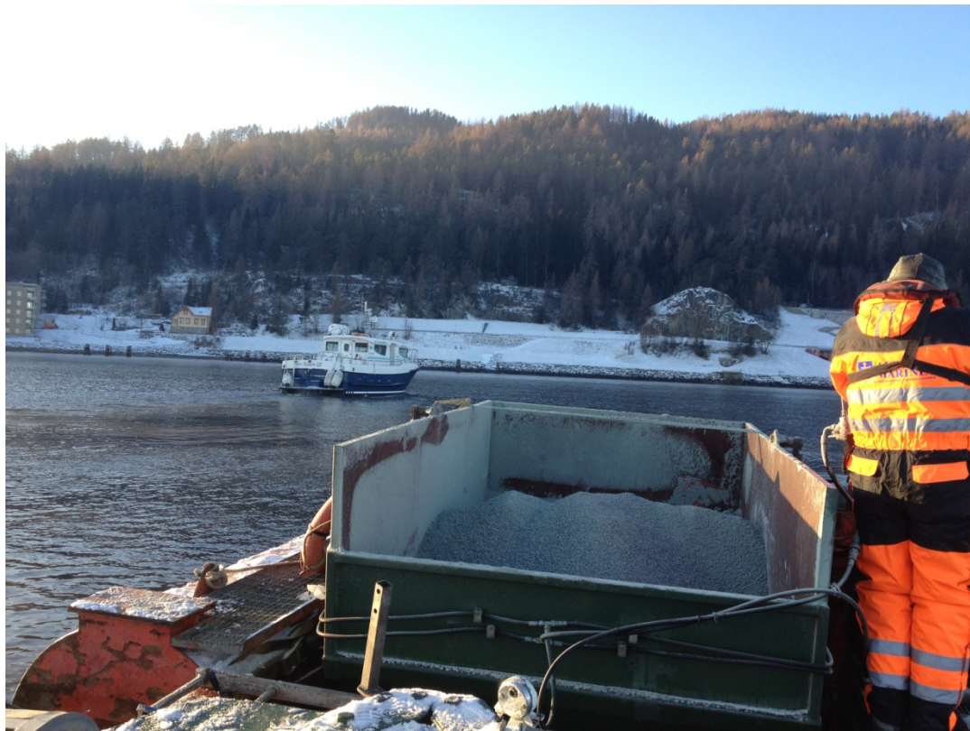
Figur 7: Fallbunnsleker for utlegging av masser, samt målebåt for overvåking av partikkelspredning (turbiditet).
