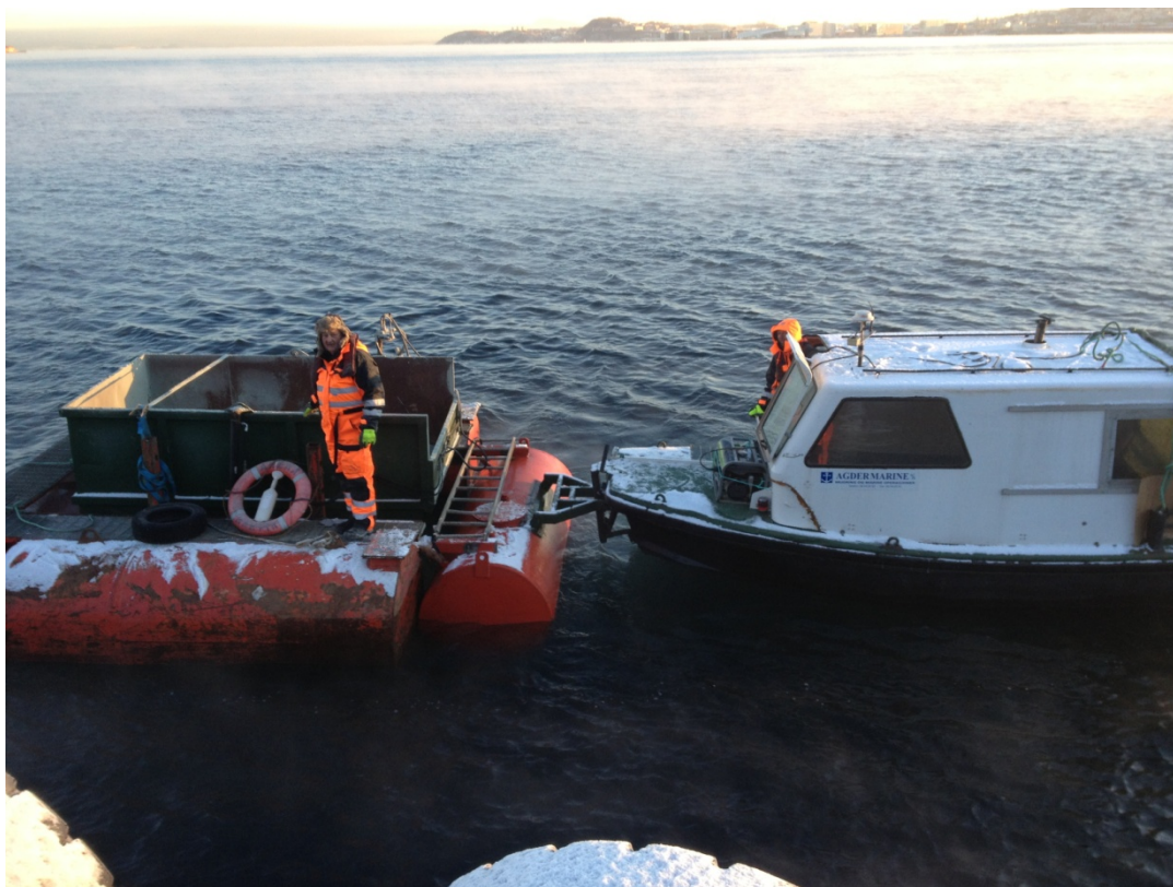
Figur 5: Fartøy og fallbunnslekter for utlegging.
