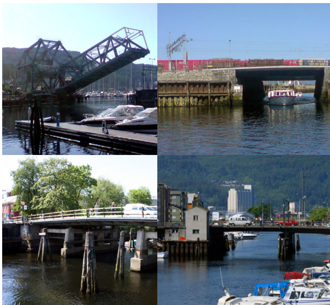
Figur 9: Bruer i Kanalen; Skansen bru (øverst til venstre), Ravnkløløpet (øverst til høyre), Brattørbrua (nederst til venstre) og Jernbanebrua (nederst til høyre)
