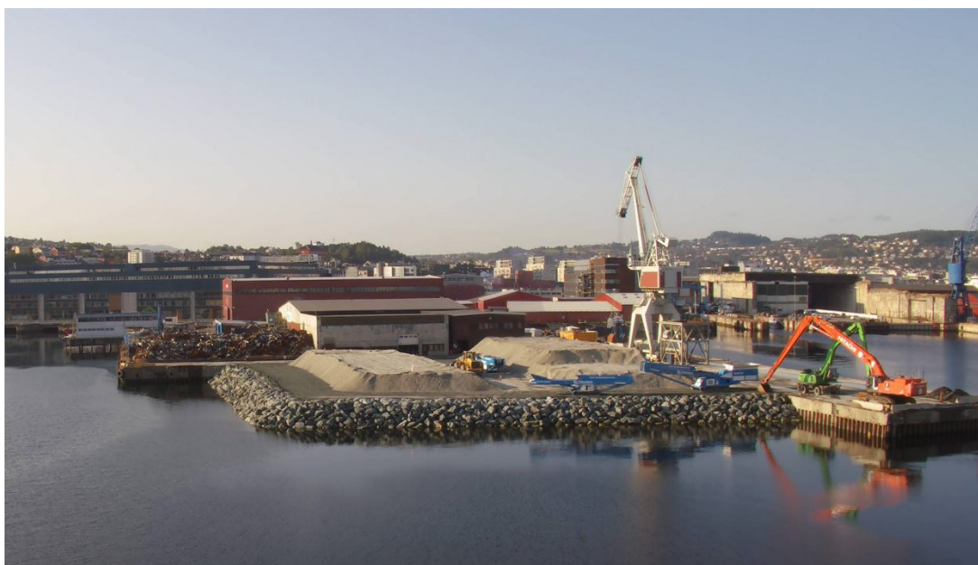
Figur 6 Ferdig strandkantdeponi i Nyhavna ble benyttet som mellomlager for tildekkingsmasser.
