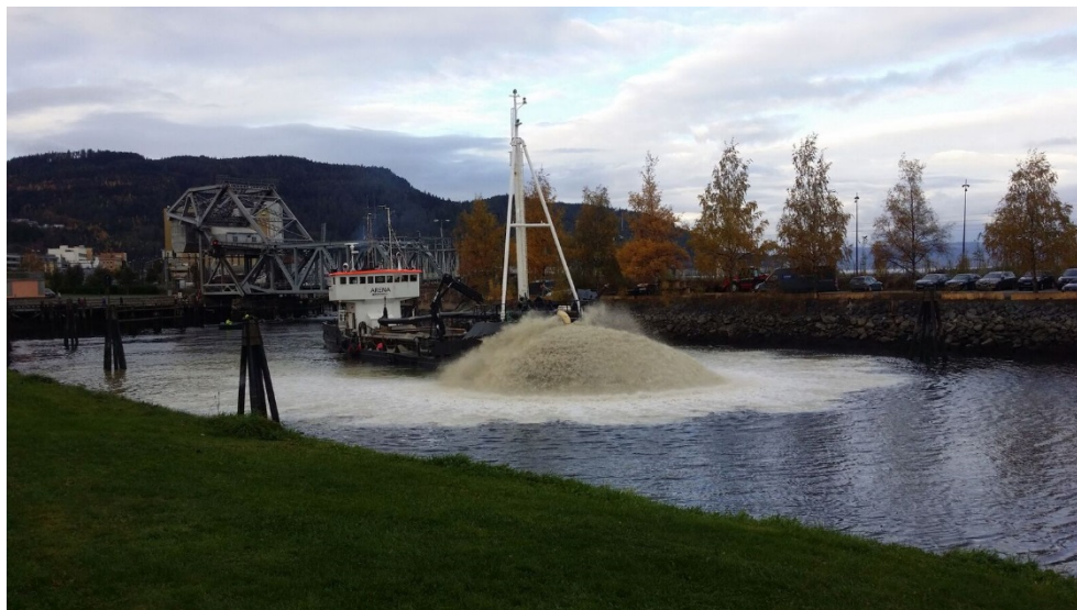
Figur 7 Tildekking i vestre del av Kanalen, ved Skansenløpet.
