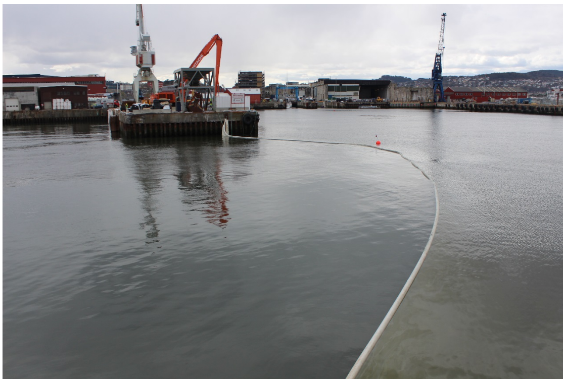
Figur 5 Partikkelsperre etablert mellom østre og vestre basseng i Nyhavna.
