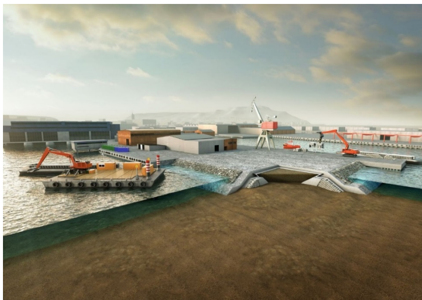
Figur 3 Strandkantdeponi ved Kullkranpiren i Nyhavna. Skisse viser oppbygging av strandkantdeponi i Nyhavna. Sjeté mot sjø har kjerne av geobager med sand / sediment og filterlag mot innfylte sedimenter.
