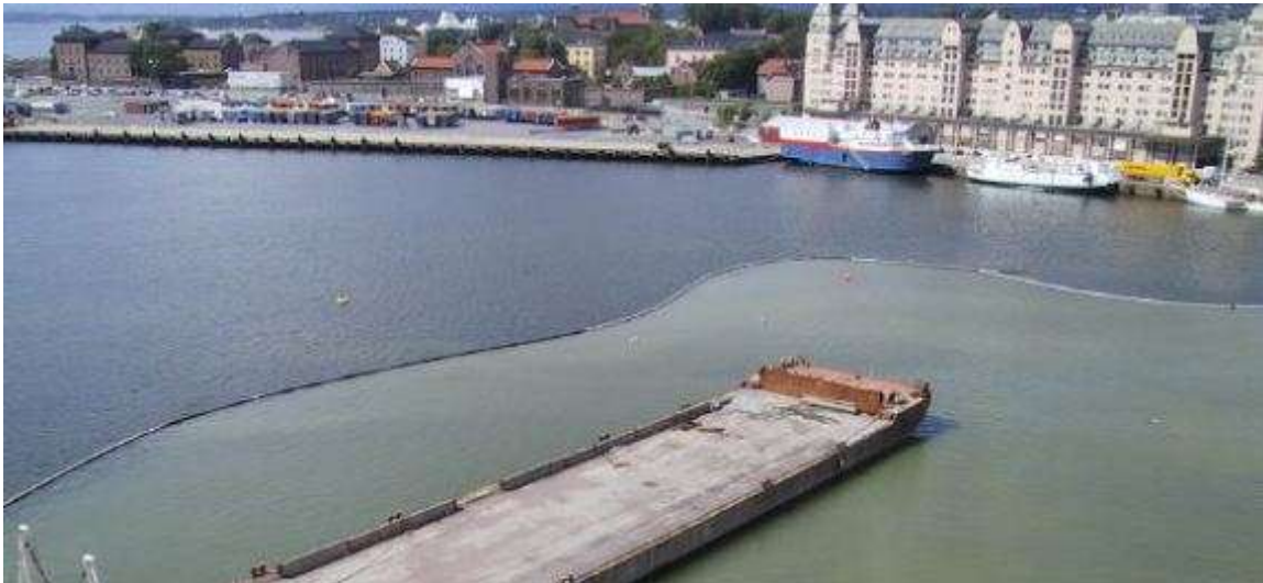
Figur 4 Foto fra bygging av Operaen i Oslo, som illustrerer virkningen av ei partikkelsperre. Foto tatt av Johs. J. Syltern AS ( www.syltern.no ).
