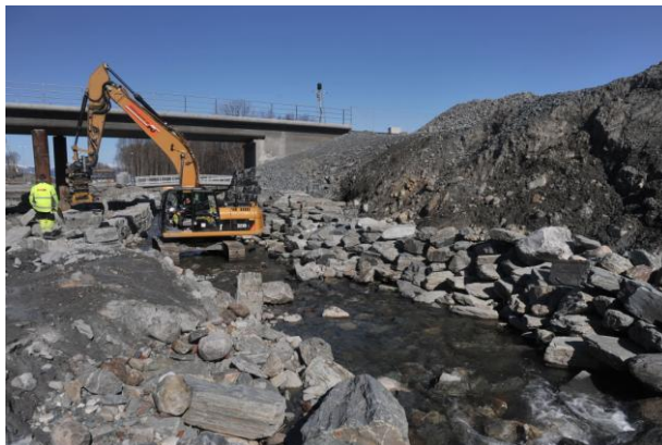
Tiltak for å bedre habitatforhold for ørret i Vikelva.
