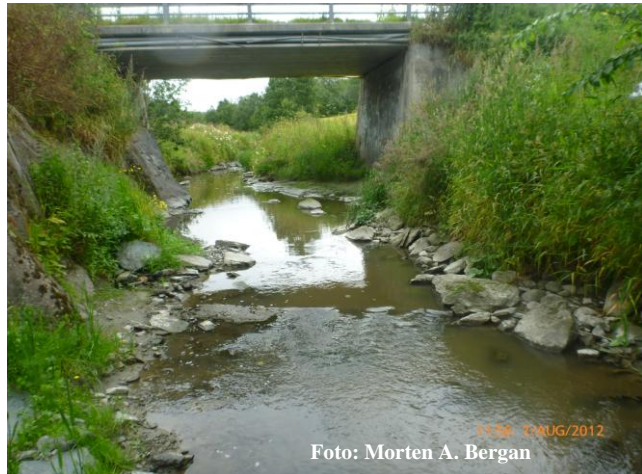
Figur 6.55. Det er marginale livsbetingelser for ørret i Ristbekken (bildet fra stasjonsområde ved Mølla).
