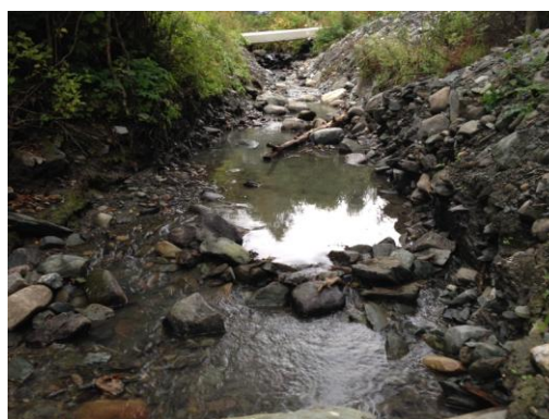
Parti ovenfor kulvert (etter tiltak)
