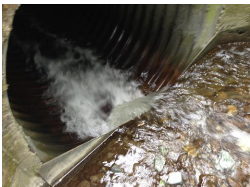
Kulvert før tiltak
