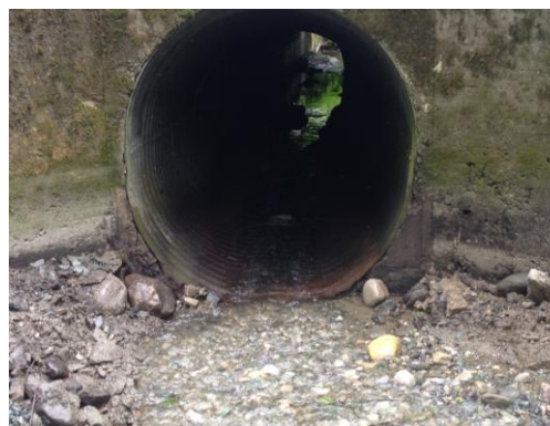
Kulvert etter tiltak
