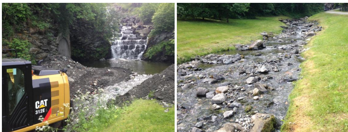
Figur 6.67. Opprensning og utlegging av gytegrus i øvre anadrom strekning juni 2014.
