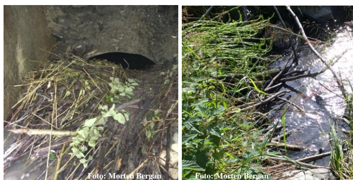
Figur 6.49. Tett kulvert under privat vei (t.v.) og tett bekkeløp (demning) like oppstrøms (t.h.)
