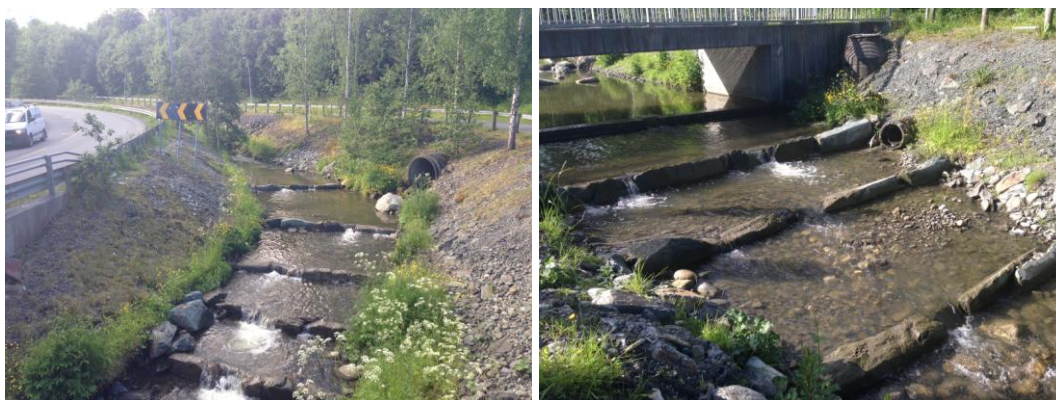
Tiltak for å bedre vandringsforholdene og utlegging av gytegrus i området ovenfor Okstadøy.
