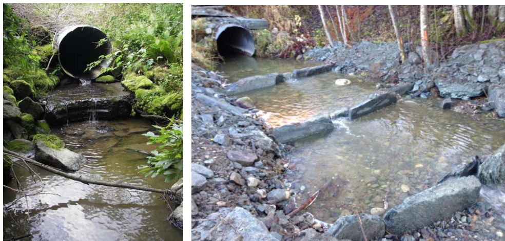
Tiltak for bedre vandringsmulighetene gjennom kulvert (før tiltak: bilde til venstre, etter tiltak; bilde til høyre).
