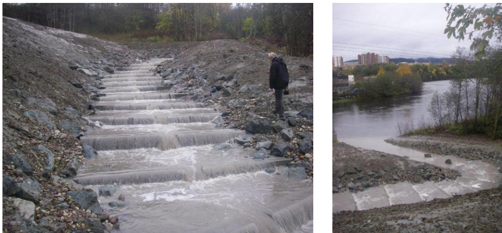
Figur 6.13. Det nye bekkeløpet i Sverresdalsbekken ble ferdigstilt oktober 2010.
