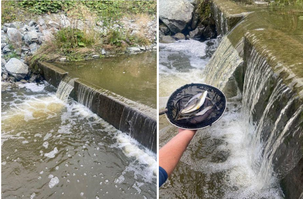
Figur 7.27. Nederste terskel er utformet ugunstig for fiskevandring, og oppvandrende ungfisk under 14 cm ser ikke ut til å passere dette punktet.
