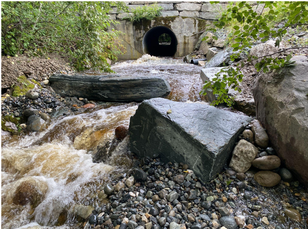
Figur 7.31. Utbedring av vandringsmuligheter for sjørret gjennom kulvert høsten 2021. Foto: Trøndelag fylkeskommune.
