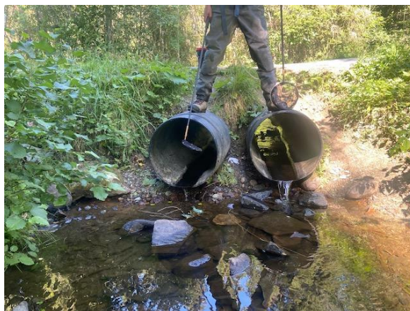
Figur 7.43. Tetthet pr. 100 m 2 av ørret stasjonsområdet i nedre del av innløpsbekk til Haukvatnet (til venstre). Til høyre: problematisk oppgangsmulighet for ørret gjennom kulvert.
