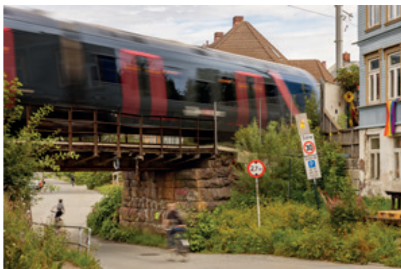
← I plansak Lademoen stoppested, er det utredet ulike bro- og kulvertløsninger i Strandveien. Bildet viser dagens situasjon. Foto: Glen Musk.
