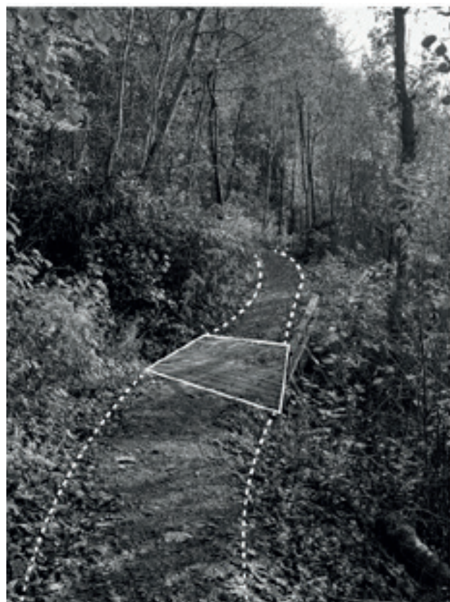
↑ Eksisterende bruer ligger i dag noe nedsenket i terrenget og bærer preg av å være slitte
