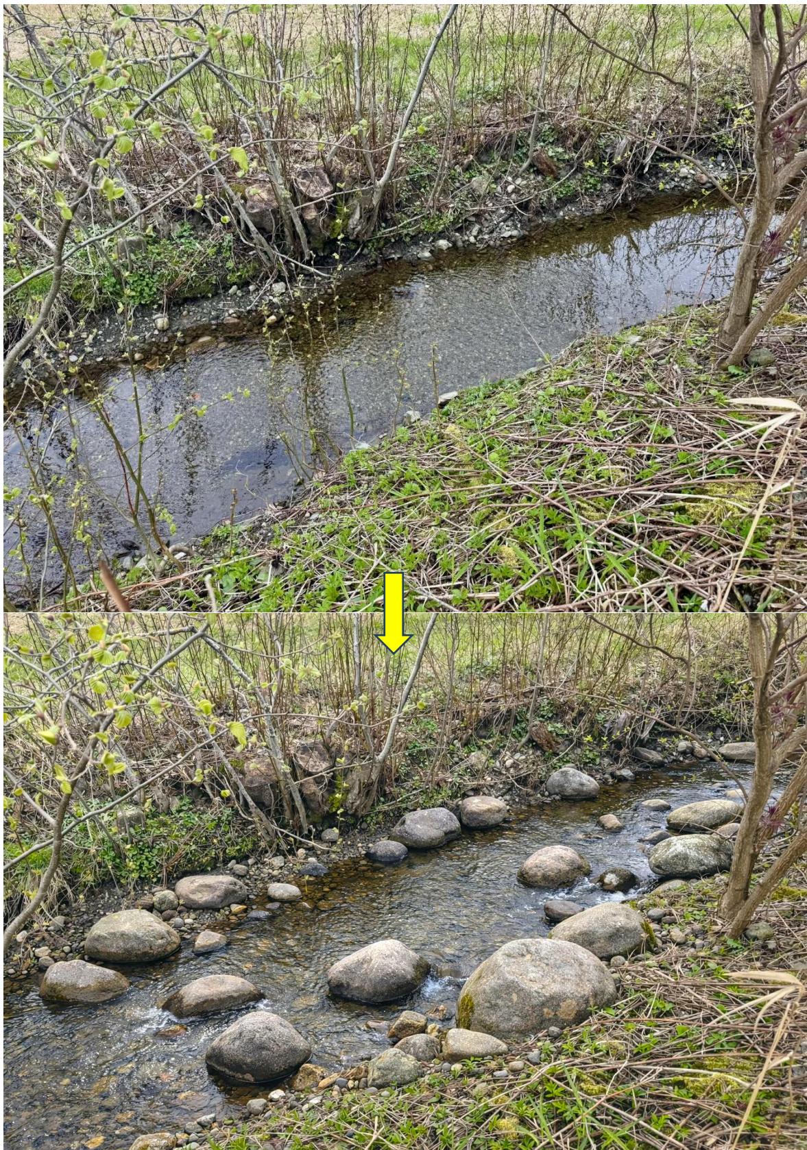
Figur 126. Restaurering ved bruk av stor og små elvestein (nederst) i dagens monotone, uproduktive og kanaliserte strekninger av Gravbekken nedstrøms Fv 707 Leinstrandvegen (øverst).
