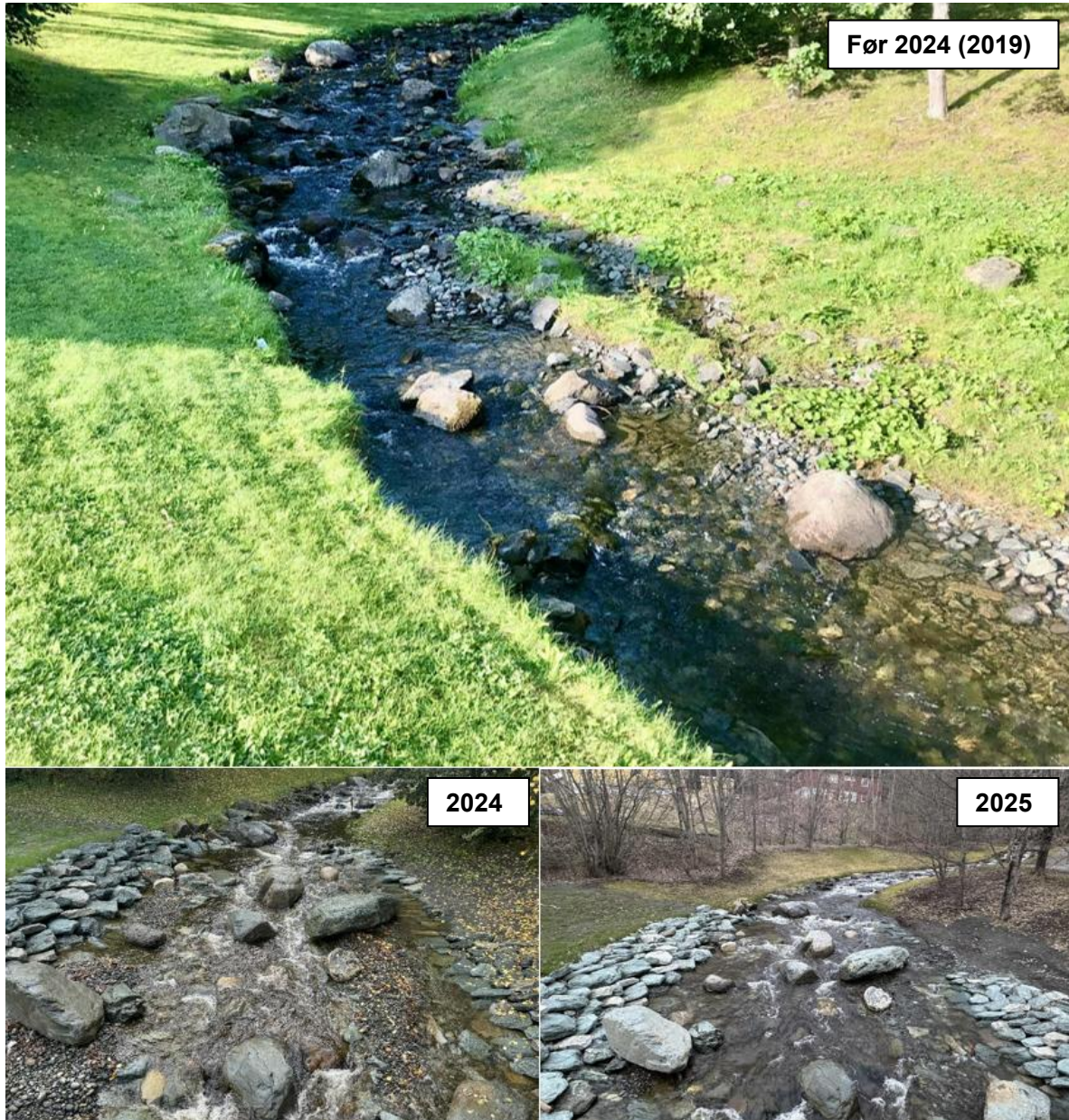
Figur 71. Det er utført utvidelse av bekkeløpet i forbindelse med sikring, og det er tilført storstein og gytegrus i etterkant av sikringsarbeidet, Foto oppover llabekken, oppstrøms brukrysningen for Hanskemakerbakken/Bynesvegen før (øverst), like etter (nederst t.v.) og nå (nederst t.h.).
