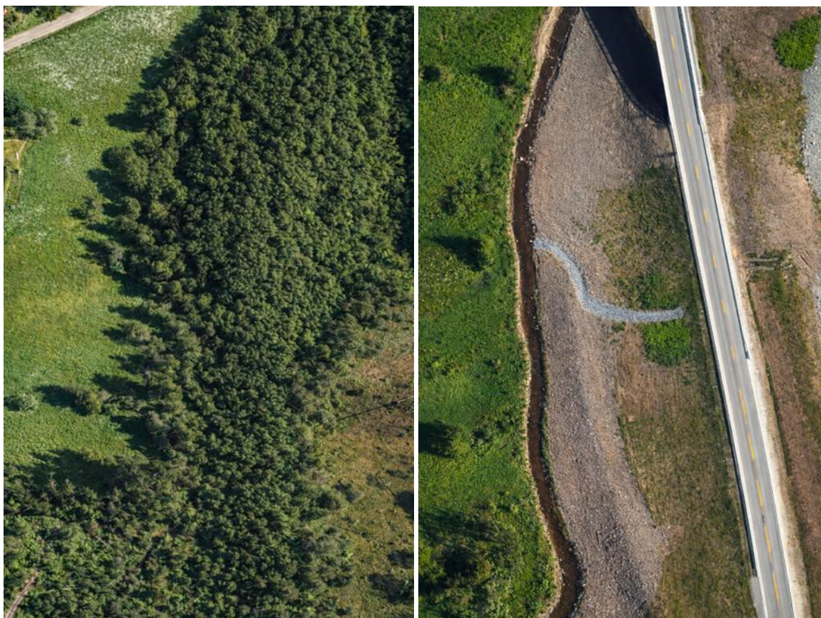
Figur 42. Et tidligere uberørt bekkeparti i Tullbekken før (2019, t.v.) og etter (flyfoto fra 2025, t.h.) anleggning av fylkesveg 704 Tanem-Tulluan. Miljøhensynet har vært fraværende i veiprojektet og ødelagt 800 meter eller mer av tidligere nøkkelområder for ørretbestanden i Tullbekken, i tillegg til at avrenning fra vei trolig har økt. Flyfoto: https://kart.finn.no/
