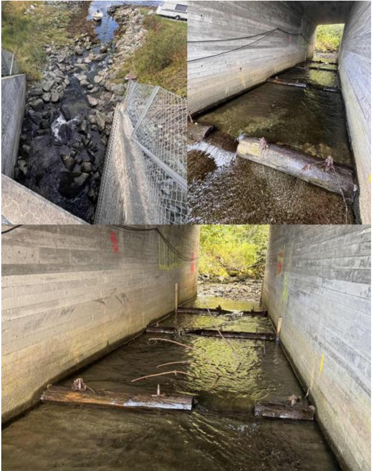
Figur 75. Oppgangsforhold fra sjø til veikulvert og gjennom veikulvert, etter montering av buner i tre. Foto på svært lav vannføring i 2025.
