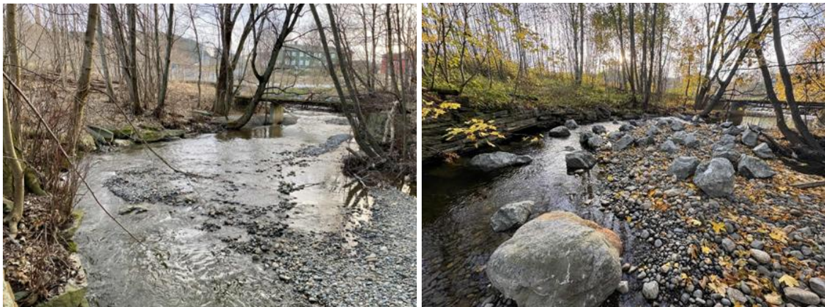
Figur 65. Før (t.v) og etter utlegging av storstein i Vikelva i 2025.
