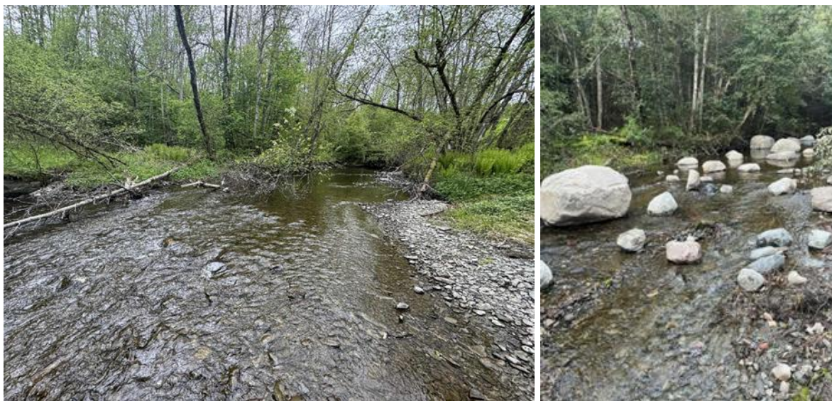
Figur 16. «Grønn sone» av Leirelva nedstrøms avkjøring til Romolslia ble betydelig restaurert ved bruk av stor elvestein i løpet av 2025. Foto oppover elva. Før (t.v.) og etter (t.h.) tiltak i 2025..
