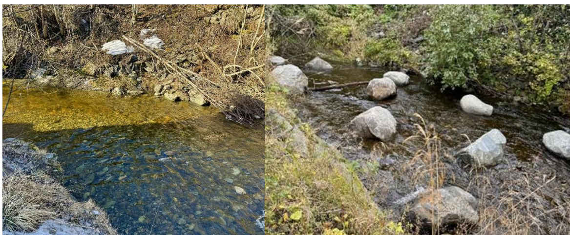
Figur 12. Før (øverst t.v.) og etter (øverst, t.h.) utlegg av stor elvestein i Leirelva ved Granbo. Foto fra 2025.
