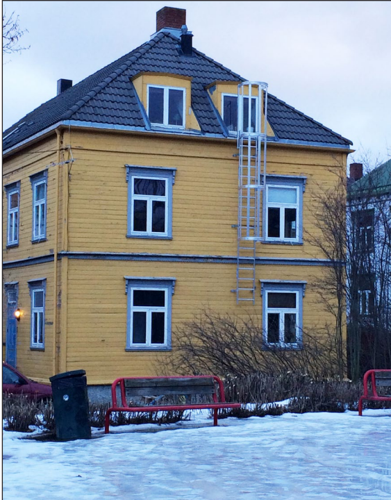
Utvendig rømning over tak anbefales ikke på vernede bygg Foto: Byantikvaren
