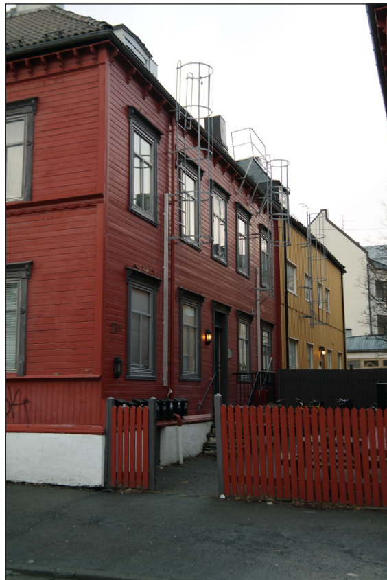
Ved gode brannkonsept kan denne type løsninger med utvendige stiger og repos unngås.
