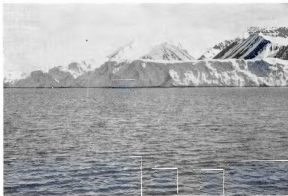
Brefronten på nært hold, høyden i fronten er ca. 70 m
