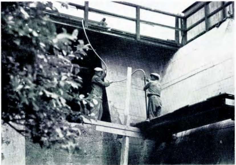
Røret skrues fast i borehullet
