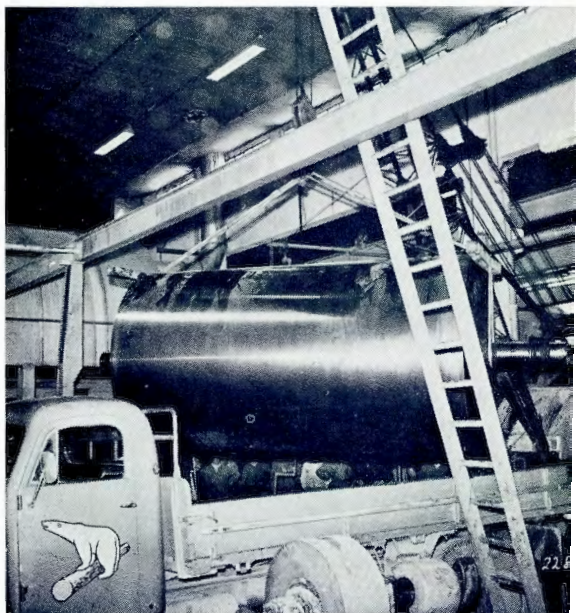
Ettørtørkeren på P.M. I løftes opp — 9 tonn — og legges pent på bilen — nedenfor.
