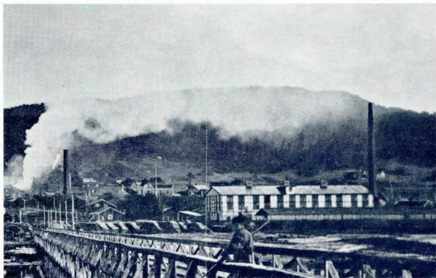
Ranheim Teglverk omkring år 1900
