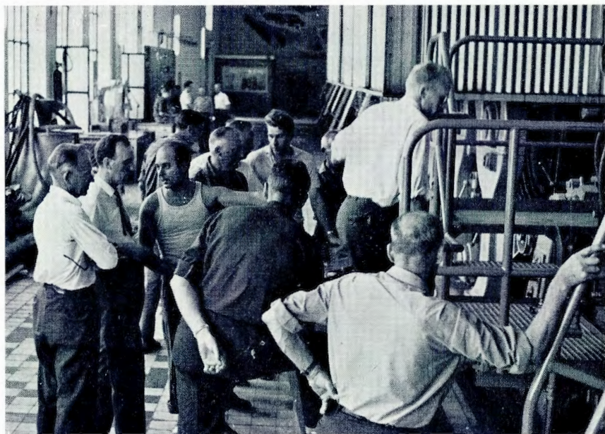
Fra Cliysak-installeringsen på P.M.V. Halvveis oppe på landgangen den finske ing. Kuimäki. Mannen med singlet i samtale med overing. Møller og ingeniør Olaussen er den tyske spesialmontør Katz
