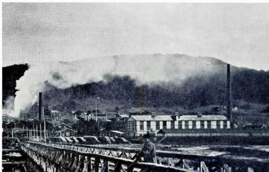
Ranheim Teglverk omkring år 1900
