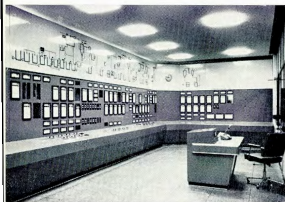
Duisburger Kupferhütte Kontrollpanelet for sulfatprod.
