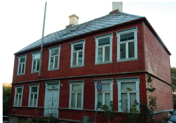
Grensen 6, 2016 Vinduene skiftet, ellers få endringer i fasade
