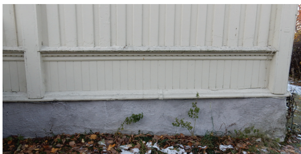
Klostergata 34 B Detalj, gurtgesims og brystning
