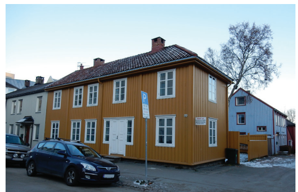
Klostergata 42 A Kombinasjon av saltak og helvalmet tak. Opprinnelig uttrykk med vinduer, taktekkning og bordkledning er forsøkt videreført
