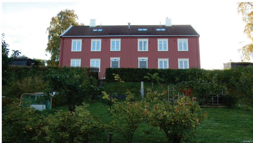
Henrik Mathiesens vei 4 med hageanlegg inn mot kvartalets kjerne Oppført 1924, Trondhjems Kooperative Bolig- og Byggeselskap
