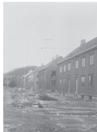
Byggevirksohmhet i Bjørnsons gt. Ca. 1922/23, Trondheim Byarkiv
