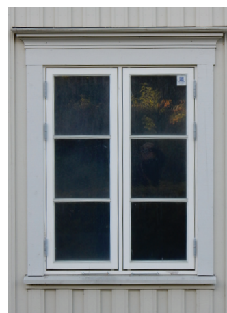
Holbergs gt. 19 Detalj, 1. etg.
