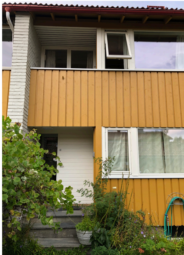
Kledning i nisjer skal males hvit - også i himling
