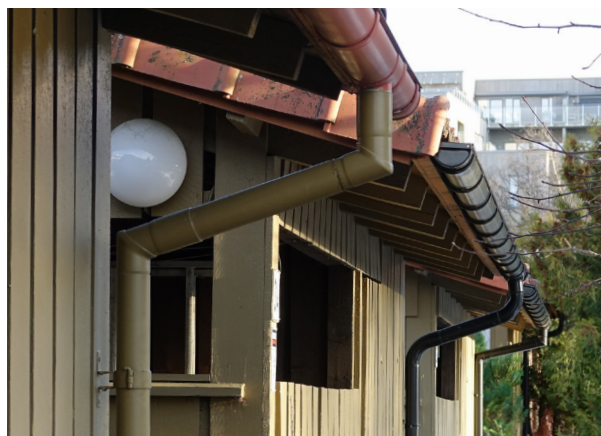
Renner og nedløp skal være i metall, med knekte bend.
