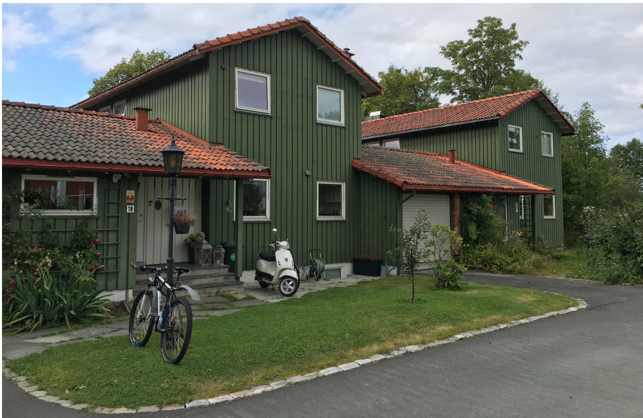
Kjedehus mot gate. Vindu som utført på nr.18 kan anlegges
