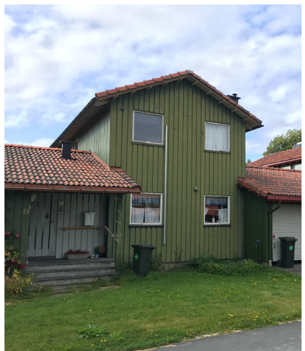
Kjedehusene har nylig blitt malt i en mørkere tone enn den opprinnelige mosegrønne som gjenstår noe falmet på ett hus.
