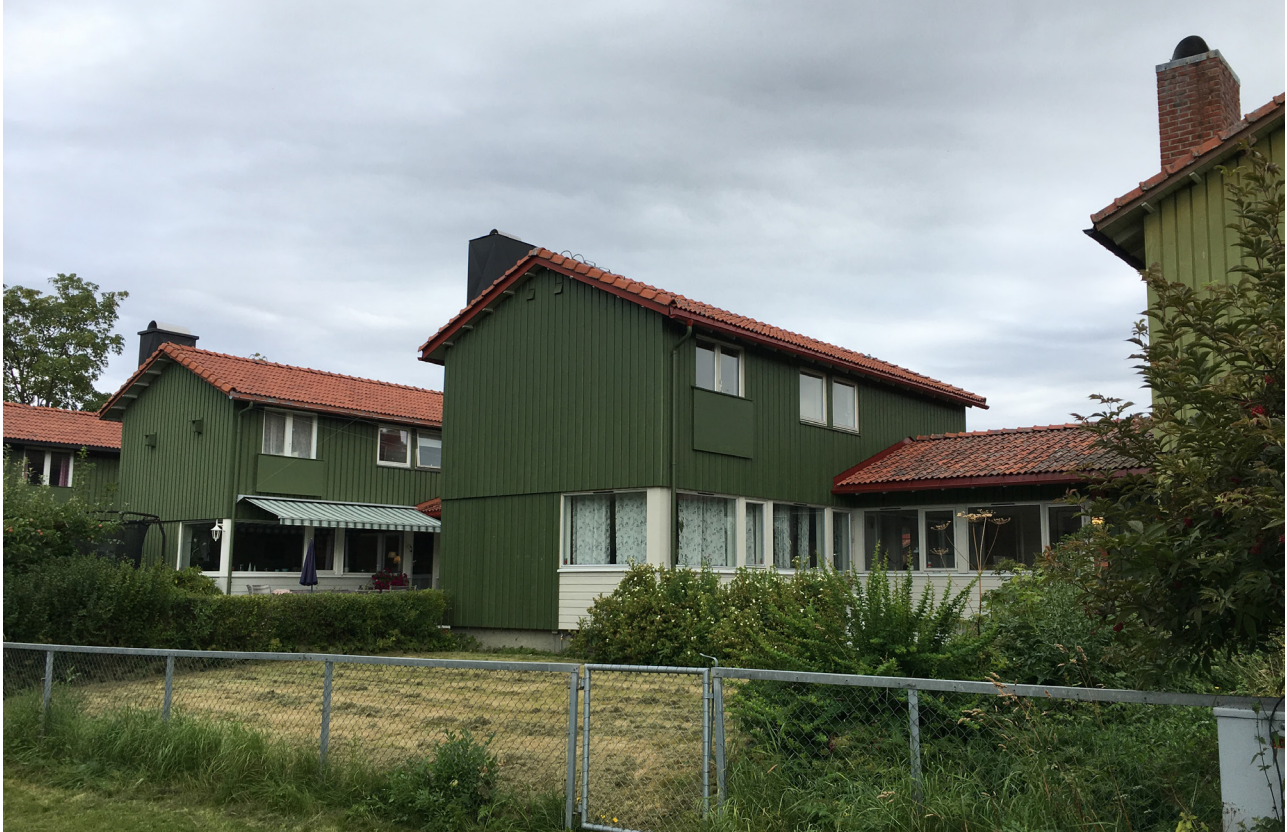
Kjedehus mot hage. Hvitmalt brystning er et særegent element som skal videreføres både på vinkelhus og kjedehus. Legg merke til skorstein med eksponert tegl. Dette er opprinnelig løsning.
