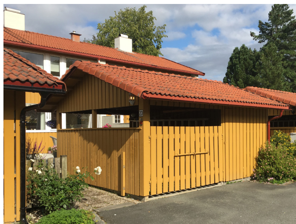
Garasje som opprinnelig
