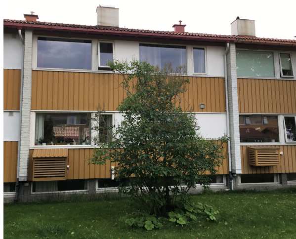
Akseptabel plassering for varmepumper, men løsning for varmepumpehus bør samordnes
