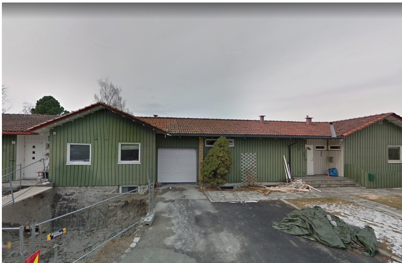
Vinkelhus mot gate. Bilde tatt under utgraving av kjeller. Foto: Google Streetview
