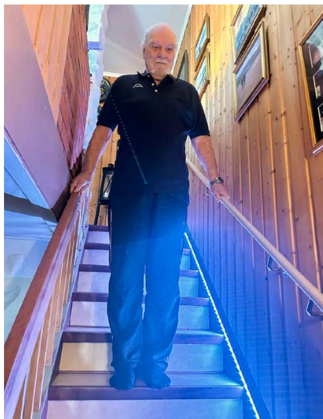
Det ble montert ei lysstripe i trappa og nytt rekkverk. Dermed ble det tryggere å gå opp og ned trappa.
