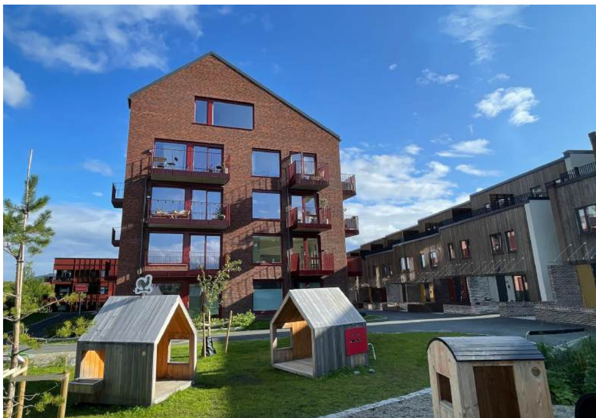
Attraktive utearealer er avgjørende for bokvaliteten. Bildet er fra Leangbukta. Foto: Byplankontoret.
