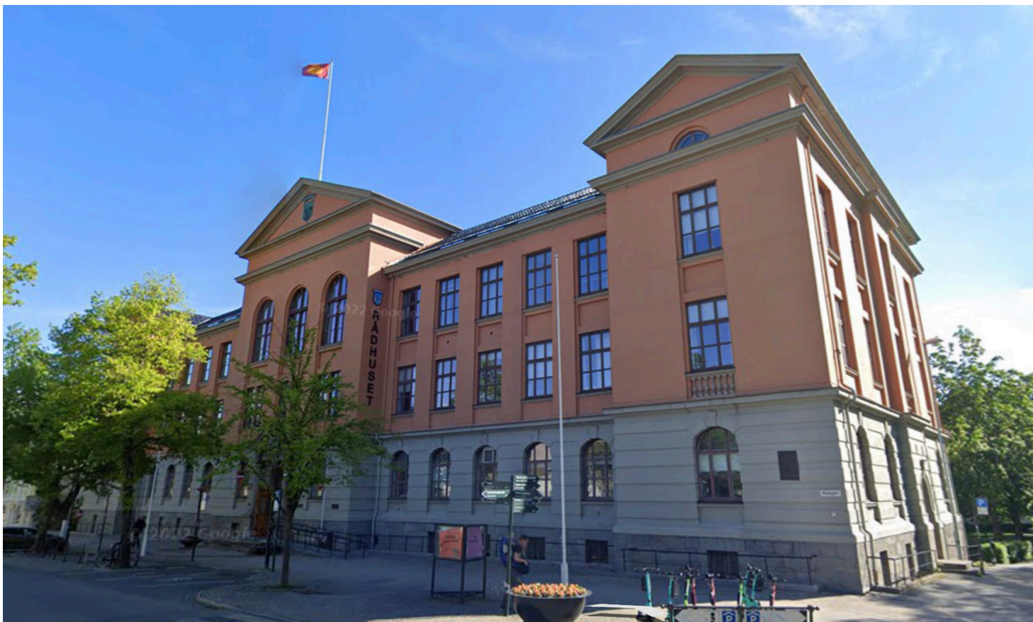
Rådhuset sett fra Munkegata – foto Google street view
