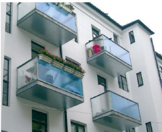
1800-talls murgårdsbebyggelse. Bakgårdsfasade med nye balkonger. Transparent utførelse. Dybde tilpas- set utstikkende privetbygg. Skjult innfesting i bjelkelag. Markveien
