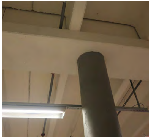
Søyle, betongdekke, bjelker
