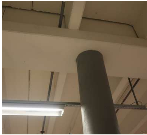
Søyle, betongdekke, bjelker
