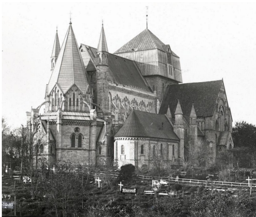
Nidaros domkirke sett fra nord-øst. Bilde tatt under oppsetting av korets ståltakverk. Hovedtårnet innebygget. Foto: NDR. Kilde: Digitalt Museum.
