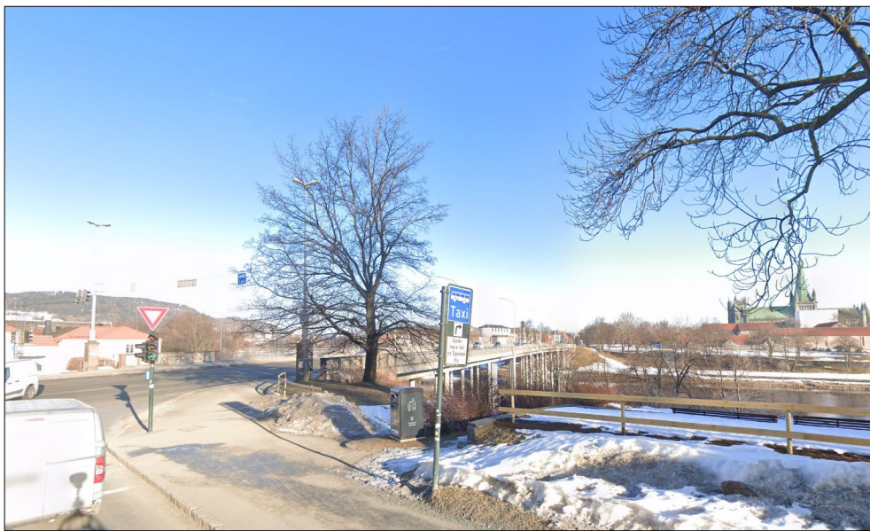
Figur 6-1: Elgeseter bru, sett i retning nordvest med Nidarosdomen i bakgrunnen. Kilde: Google.
