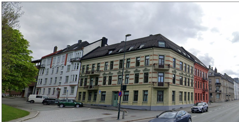
Figur 6-16: Elgeseter gate 9 og 11, sett i retning sørøst. Kilde: Google.
