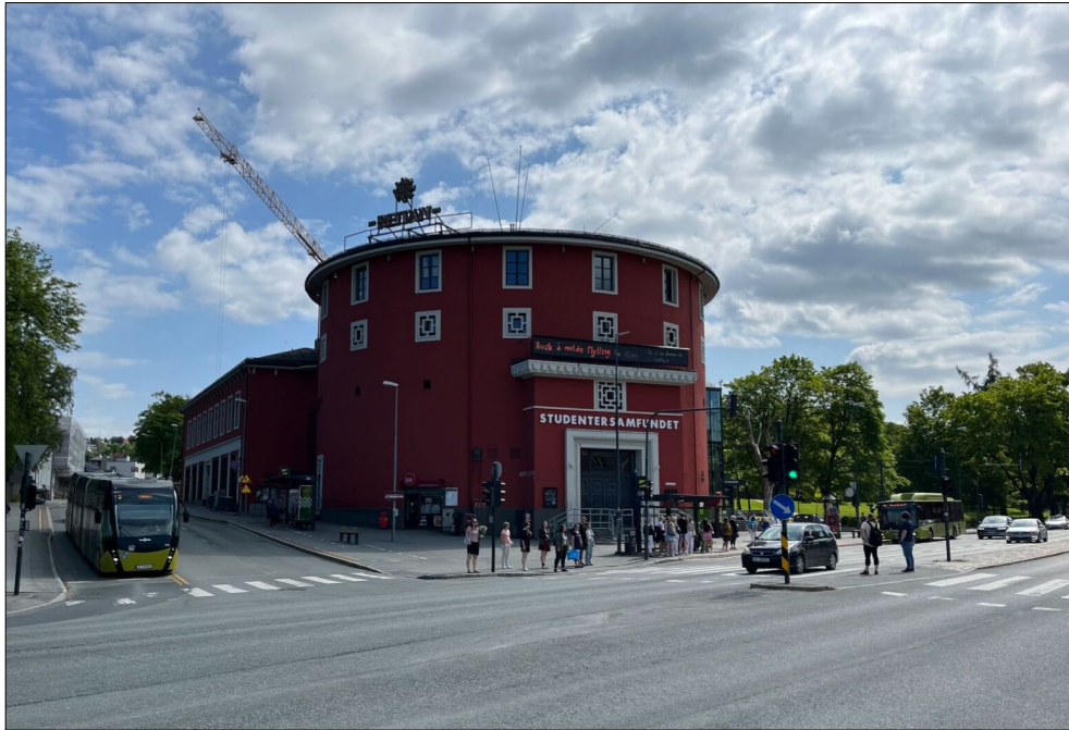
Figur 6-2: Studentersamfundet, sett i retning sørøst. Klostergata til venstre. Kilde: COWI AS
