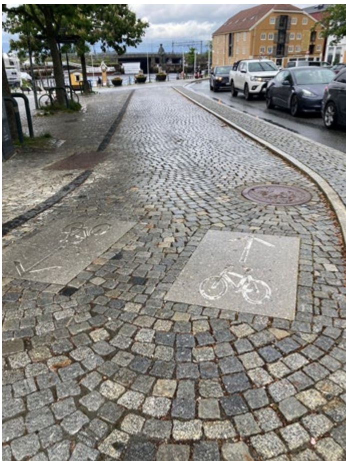
Figur 6-3 Eksempel på dekke og symbolbruk for sykkel. Bildet er fra sykkelanlegg ved Ravnkloa. Bilde: Ingrid Haugan Hansen
