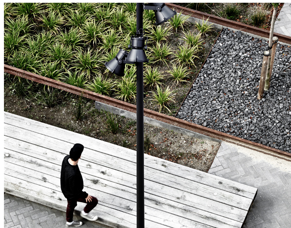
Fig. 4-17: Eks. gjenbruk av materiale. Jernbaneskiner. Godsterminal Aalborg. Foto: Wichmann+Bendtsen
