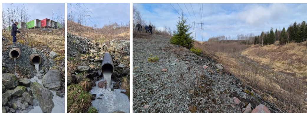
Figur 5 Overvannshåndtering, kraftlinjer og stabiliserende tiltak i øvre del av Kvetabekken. (Bilder fra befaring 2025)
