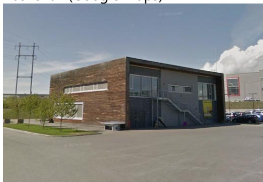
Administrasjonsbygg (Google maps)
