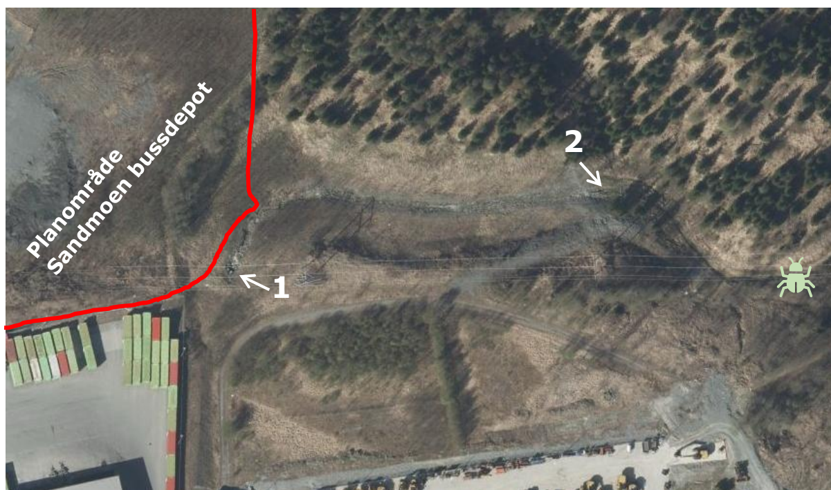
Figur 5: oversikt over hvor befaring ble utført. 1) Rør oppstrøms hvor vannet først kommer over bakken, 2) rør nr 2. Insektikonet er plassering av bunndyr og vannprøvetakingsstasjon for prøver tatt i oktober 2025 [18]. Rød linje er tilnærmet plangrensen til tiltaket.
