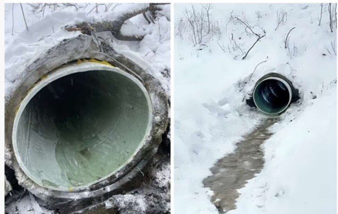
Figur 3-8. Nyhetsartikkel i Adresseavisen april 2024 om vegstenging ved rv. 706 Dorthealyst på grunn av nødvendig utskifting av stikkrenne. Kilde: Adresseavisen.
