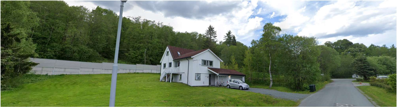
Figur 6-8. Dagens støyskjermer langs rv. 706 sett fra Sivert Dahlens veg i 2022. Kilde: Google Street View.
